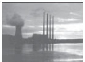
Geração de Energia
